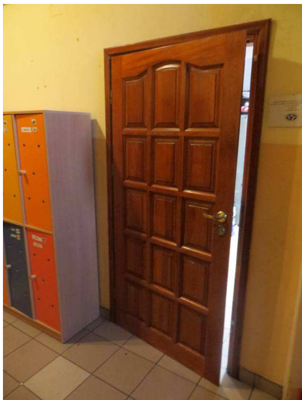
Drzwi wewnętrzne przeznaczone do wymiany na EI 30
