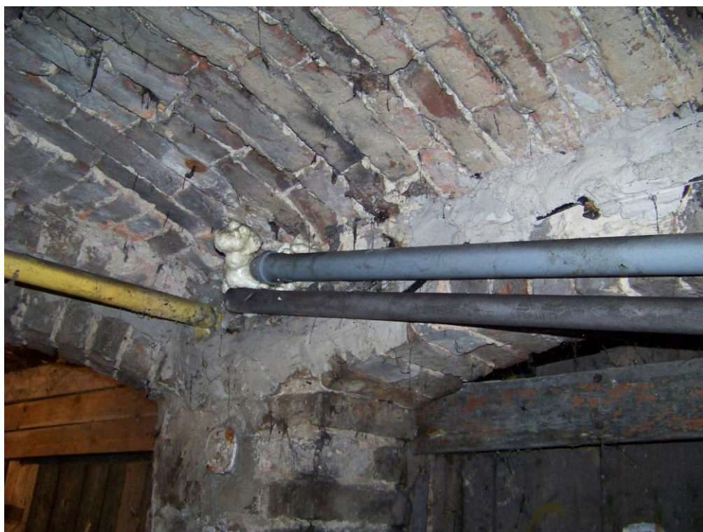
Fot. 2. Rura gazowa, rura wodna w otulinie oraz rura kanalizacyjna PVC na korytarzu piwnicznym.
