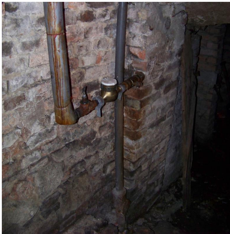
Fot. 3. Połączenie rury spustowej PVC z pionem żeliwnym oraz wodomierz na korytarzu piwnicznym
