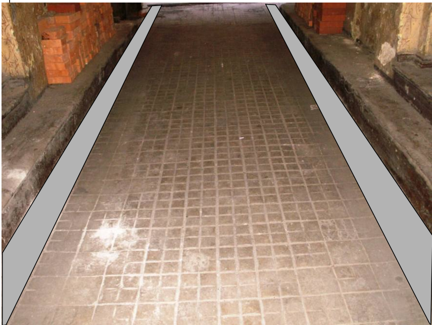
BRUK W BRAMIE PRZEJAZDOWEJ- DO ODTWORZENIA, UZUPEŁNIENIE WZDŁUŻ ŚCIAN KOSTKĄ GRANITOWĄ
