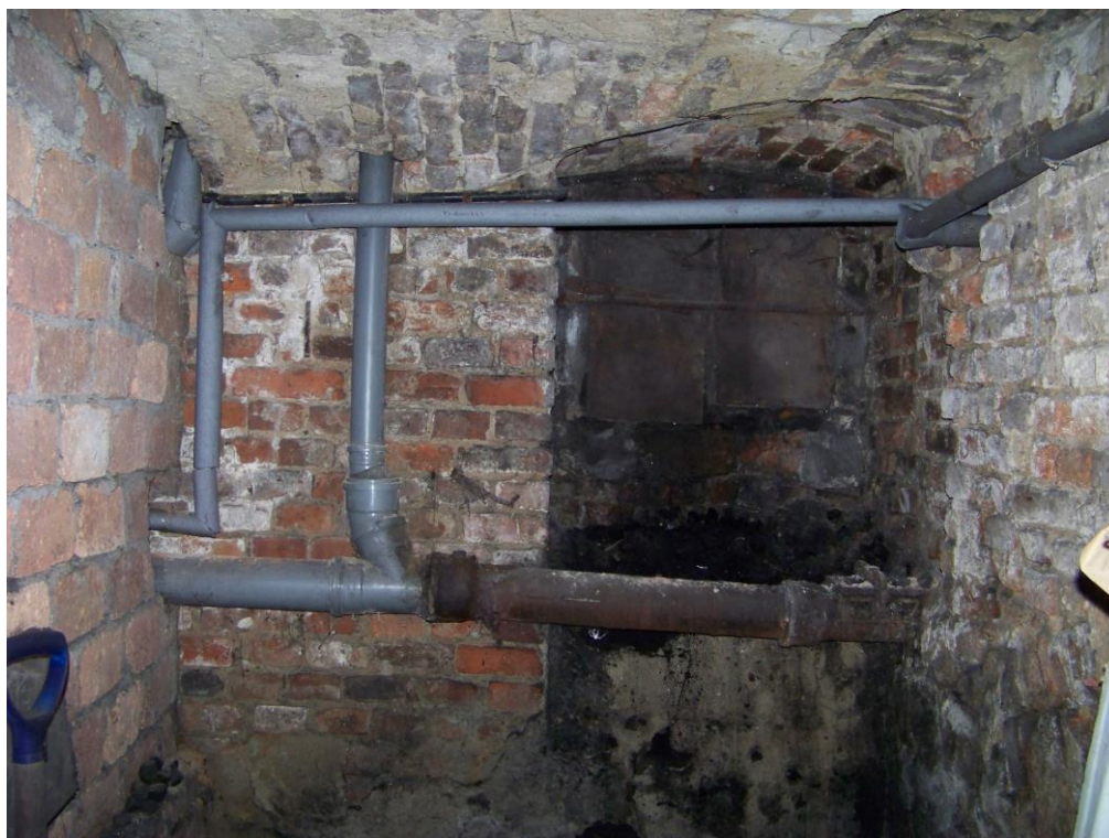
Fot. 1. Połączenie rury PVC z rurą żeliwną Ściana zewnętrzna od strony podwórza
