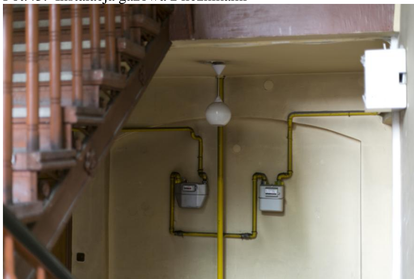
Fot.46. Instalacja gazowa z licznikami
