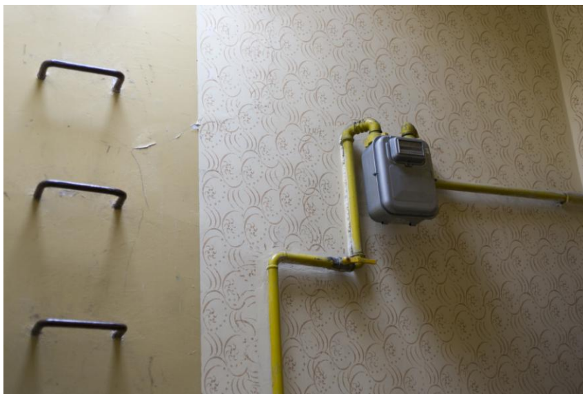
Fot. 47. Instalacja gazowa z licznikiem na poddaszu
