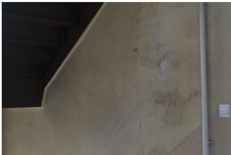
Fot.31. Złuszczająca się farba na tynku
