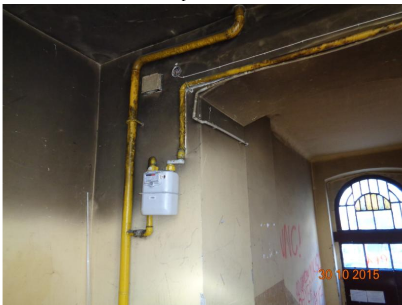
Fot.33. osmolone ściany i sufit parteru
