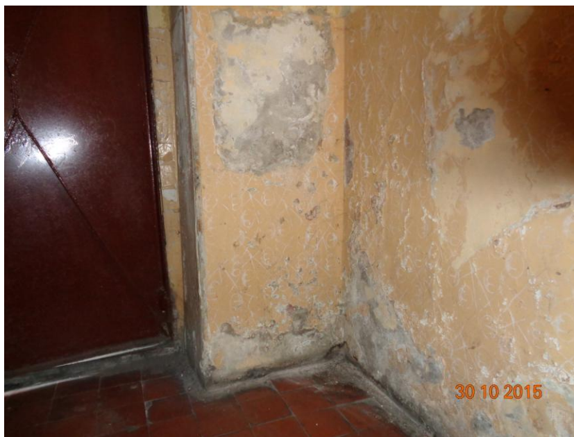
Fot.25. Widok na zawilgocone ściany parteru (widok od strony wyjścia na podwórze)
