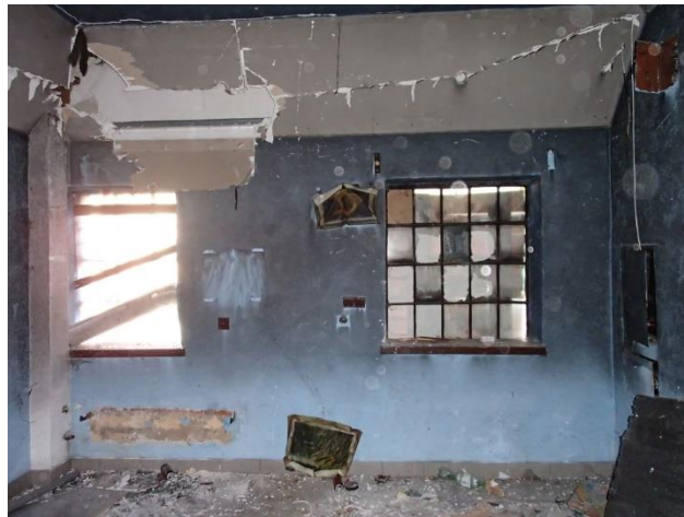
5. Wnętrze- pomieszczenie nie podlegające wyburzeniu, otwór okienny po prawej przewidziany do przekształcenia na wejście do pomieszczenia.
