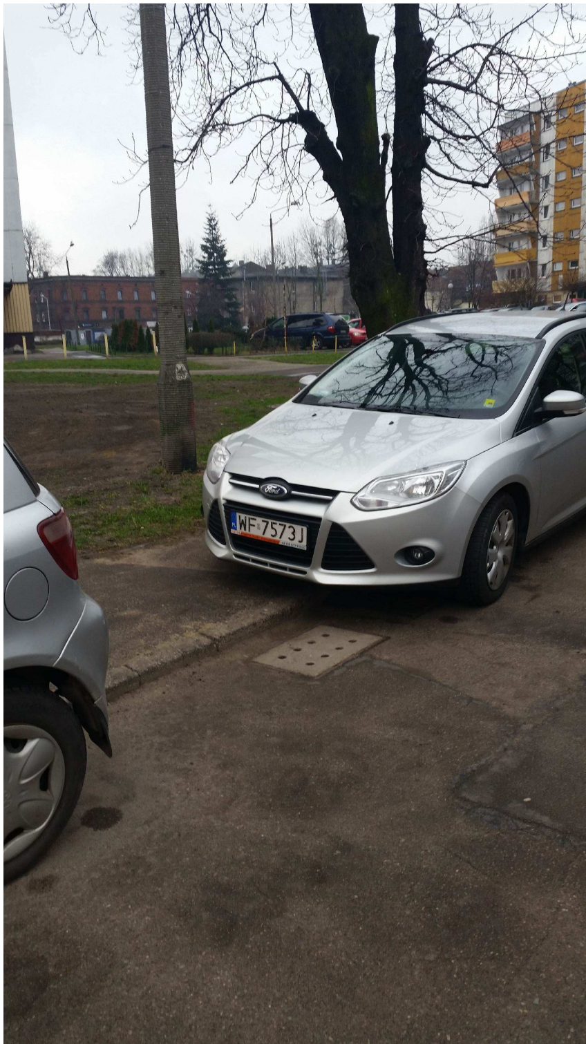
Zdjęcie nr 4 – Fragment istniejącego krawężnika przeznaczony do rozbiórki, chodnik z masy mineralno - bitumicznej przeznaczony do rozbiórki oraz wpust z kratką żelbetową przeznaczony do czyszczenia
