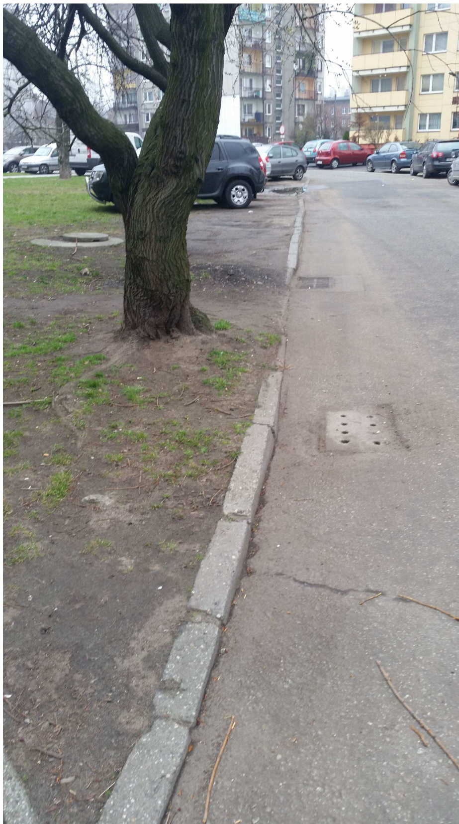
Zdjęcie nr 3 – Istniejący krawężnik przeznaczony do rozbiórki oraz wpust z kratką żelbetową przeznaczony do czyszczenia
